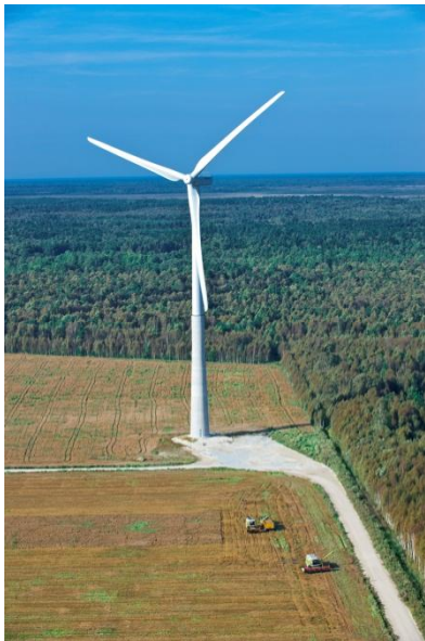
Kuva 7. Kuva 3 MW tuulivoimalasta, jonka tornin alaosa on betonia ja yläosa terästä sekä periaatekuva tuulivoimalasta (Lähteet: WinWind Oy, planete-energies.com)
